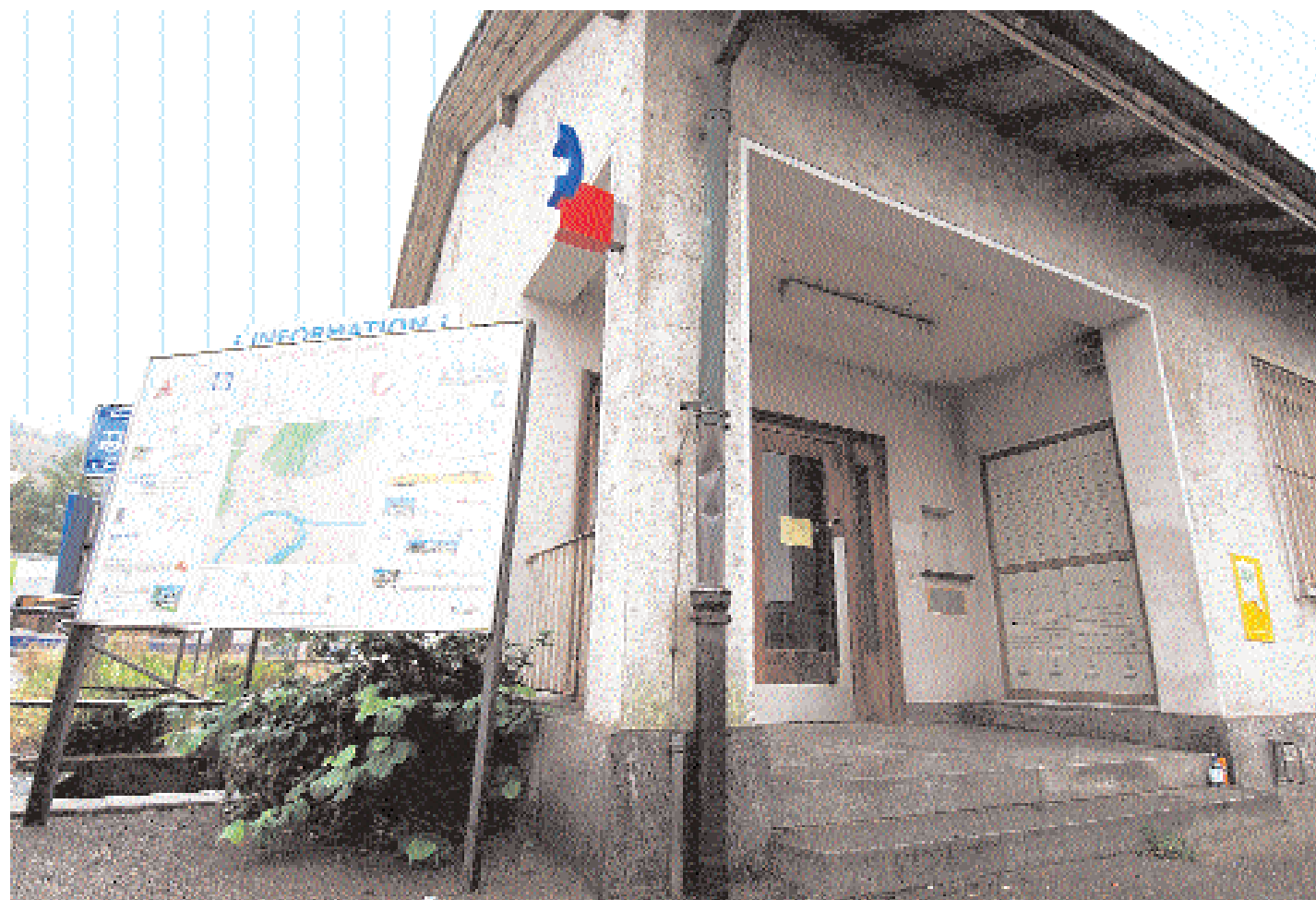
Hier entsteht viel Platz für das neu gestaltete Bahnhofareal: Die alte Bürener Post muss in den nächsten Tagen dem Umbauprojekt weichen, das aber noch längere Zeit auf sich warten lässt. Bild: Sandra Sutter
